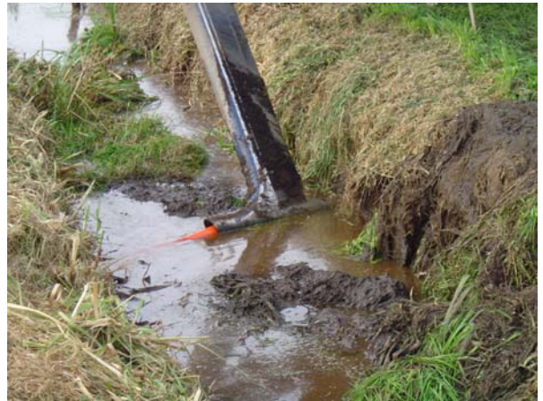
De drainage wordt sleufloos aangelegd
