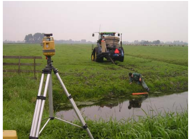
De drainage wordt sleufloos aangelegd
