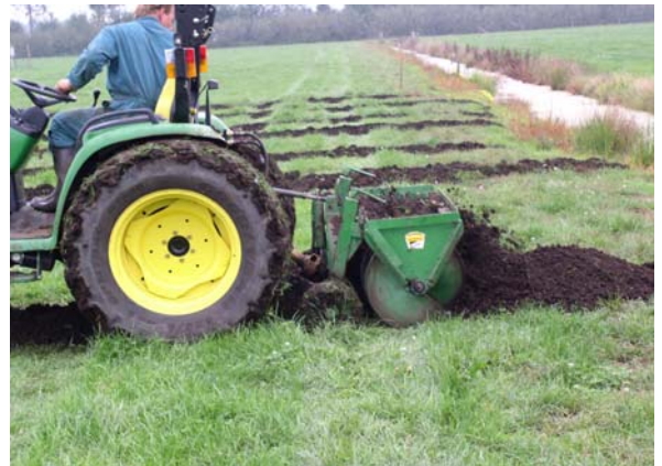
De geul waarin de buisdrainage ligt wordt opgevuld en aangereden
