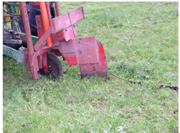
De drainage wordt sleufloos aangelegd
