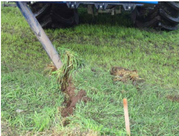
Er is geen noemenswaardige schade aan het perceel zichtbaar
