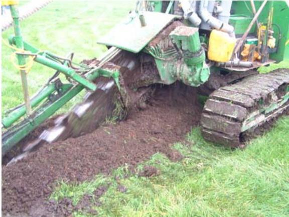
De buisdrainage wordt gelegd met een kettingfrees.
