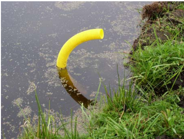
De moldrainage wordt afgewerkt met een flexibele buis
