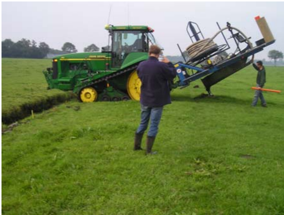
De drainage wordt aangelegd met een draineercombinatie achter een trekker op rupsbanden
