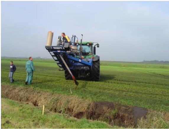
De drainage wordt aangelegd met een draineercombinatie achter een trekker
