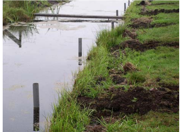
De buisdrainage wordt afgewerkt met een pvc-buis
