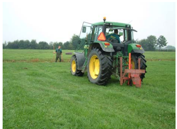
De volledige combinatie aan het werk tijdens de aanleg van moldrainage
