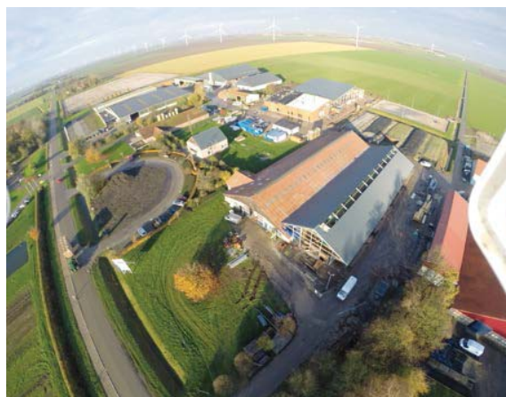
'Voor opleidingen gericht op de primaire productie heeft CAH Vilentum in Dronten unieke faciliteiten.' In mei 2015 worden de Flevolandstal en de nieuwbouw van het weidebedrijf geopend
