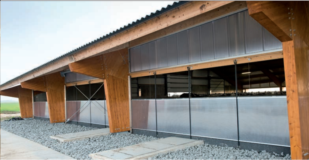
De luchtinlaat aan de zijkant van de stal is tot één meter handmatig te regelen
