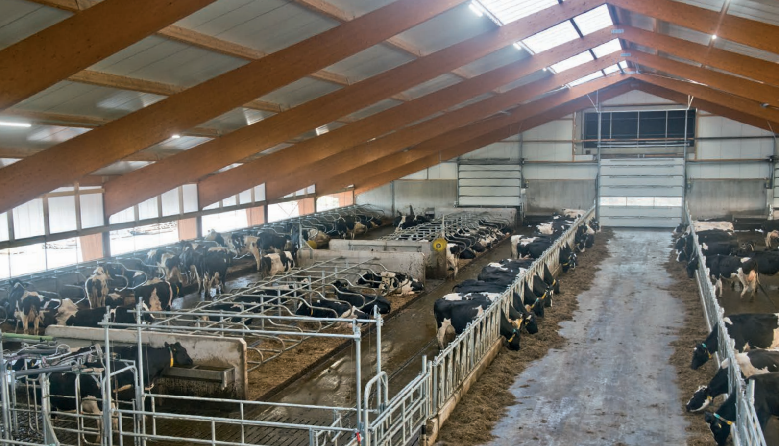
Doordat de nok dicht is, kan de lucht alleen via de luchtwasser, aan de achterkant van de stal boven de voergang, de stal verlaten
