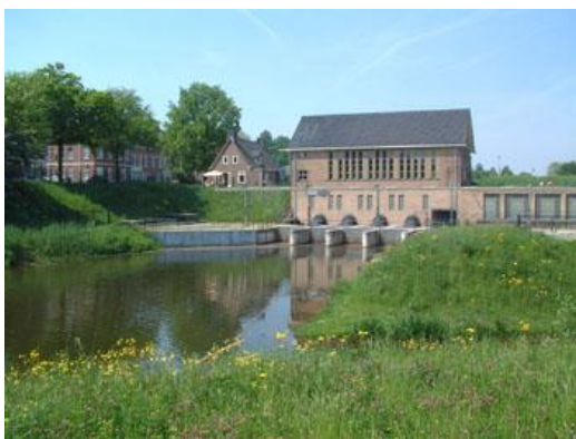
Figuur 5.2 Hollands-Duits gemaal grenst aan de Nijmeegse wijk de Ooijse Schependom en is de kunstmatige afwatering van de landbouwgebieden in dijkkring 42 (foto van nijmegency).
