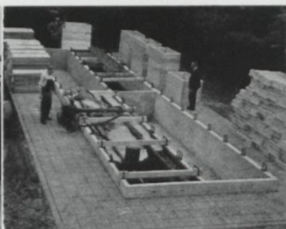
Door langdurig drenken in Superwolmanzout-D
