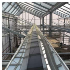
Figuur 3. Thermische collector voor de lichtbundel
