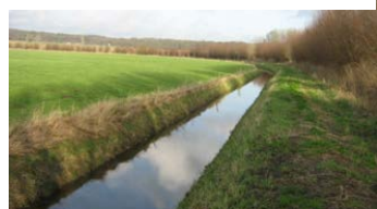
Foto 16 Talud met knotwilgen (RL)
