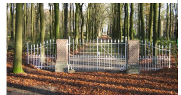
Foto 22 Hekwerk na restauratie (RL)
