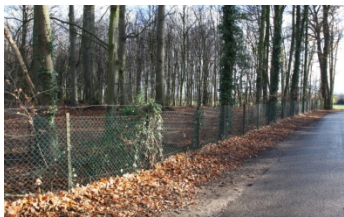
Foto 6 Tramspoor hekwerk (BdM)
