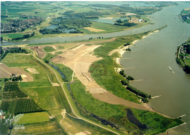
Door de ontgraving van de verontreinigde toplaag wordt de contour van de nevengeul zichtbaar (fotografie: Aerofoto Brouwer Brummen).
