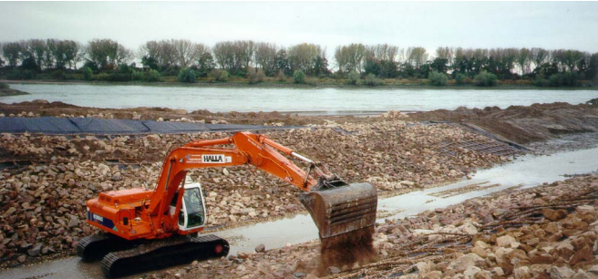
Aanleg van bodembescherming aan de benedenstroomse zijde (fotografie: J.A. van Rijsbergen, Royal Haskoning)
