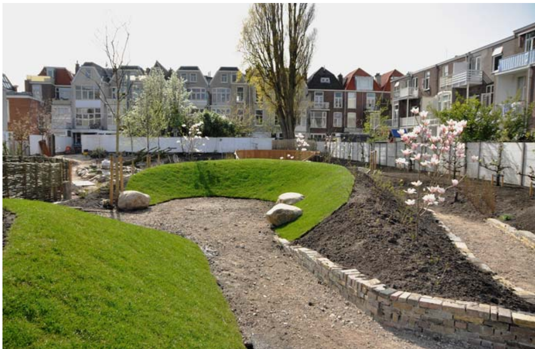
Stadstuin tijdens de aanleg. Foto: Nelleke Mineur.
