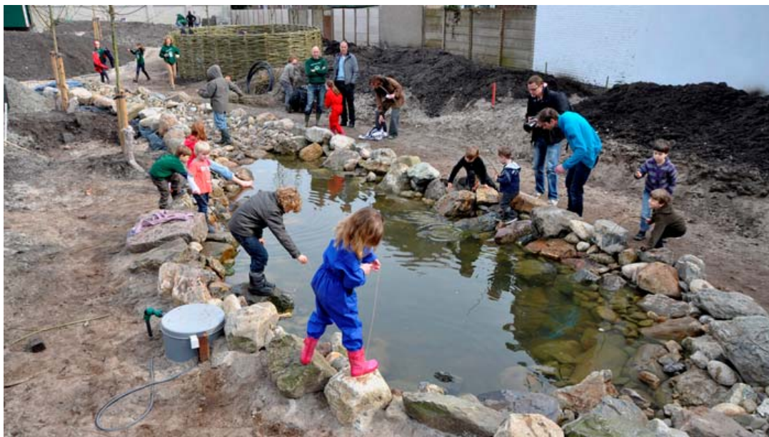
Kinderen spelen aan het water tijdens de aanleg.
