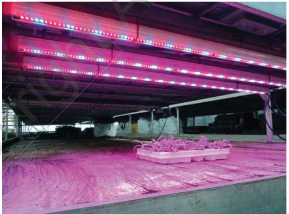
▲ LED's werden gemonteerd onder de teeltlaag, zodat een tweede teeltlaag werd bekomen
