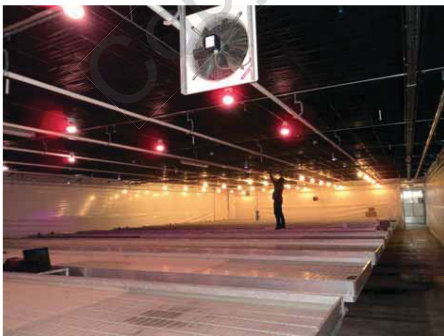
▲ Bij Gediflora wordt een deel van de gloeilampen vervangen door LED's.
