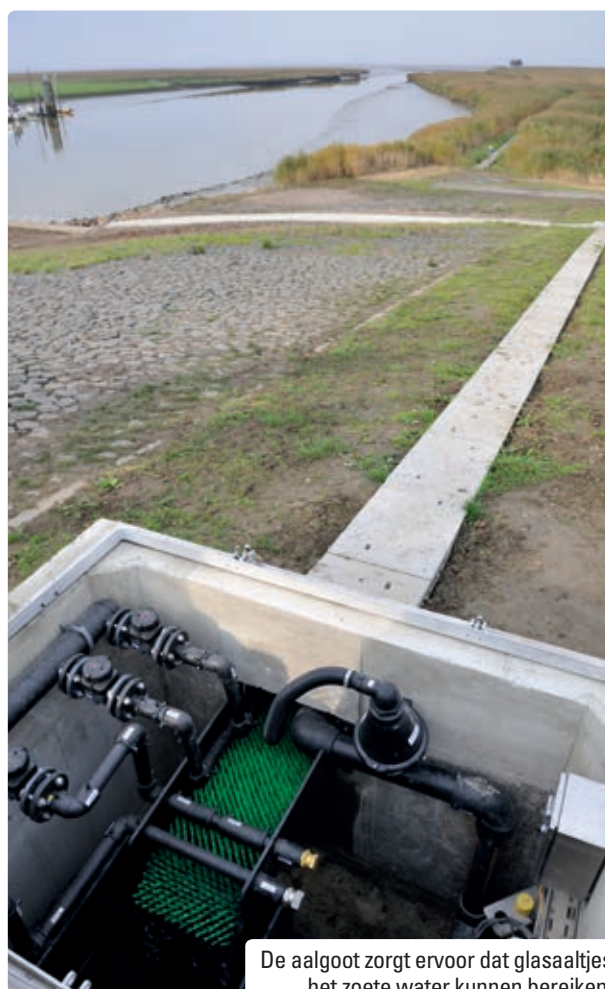
De 'aaldouche' bij Nieuwe Statenzijl lokt glasaal naar een aalpassage. De glasalen klimmen vervolgens via een borstelbaan de dijk over. Bij het onderzoek naar de werking van de passage wordt ook gebruik gemaakt van infraroodbeelden.
