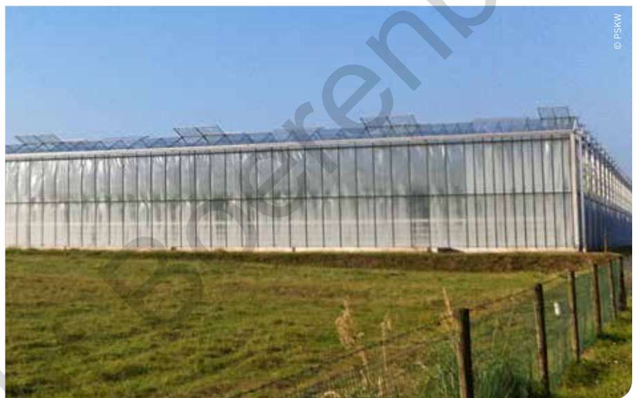
Ventilatie via de luchtramen in een standaardserre.
