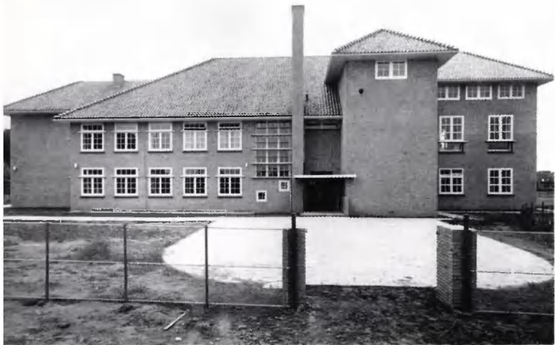
Het gebouw van het Bodemkundig Instituut aan de Verlengde Oosterweg te Groningen.
