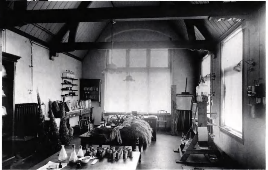
Het laboratorium van de landbouwkundige. De opening van het nieuwe gebouw, op zaterdag 13 februari 1904, vond plaats in dit lokaal.
