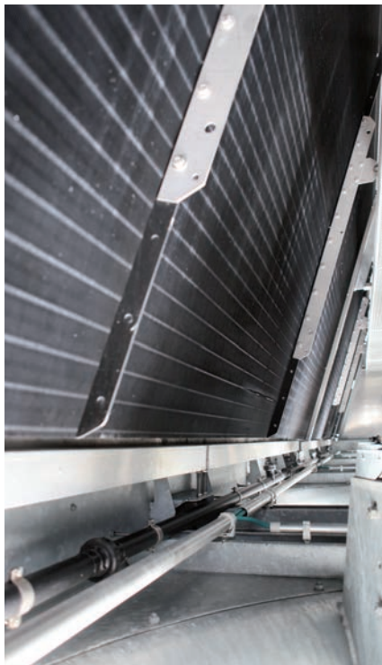
Foto 2: Opstelling van een groot aantal schuingeplaatste platen in de hybride droge koeler.
