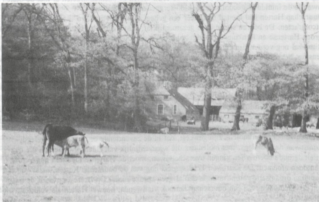
foto 12: Boerderij 2 is gebouwd op de overgang van droge gronden met bos en akkers en de lagere gronden met grasland. De bomen zijn overblijfselen van het vroegere hakhout.
