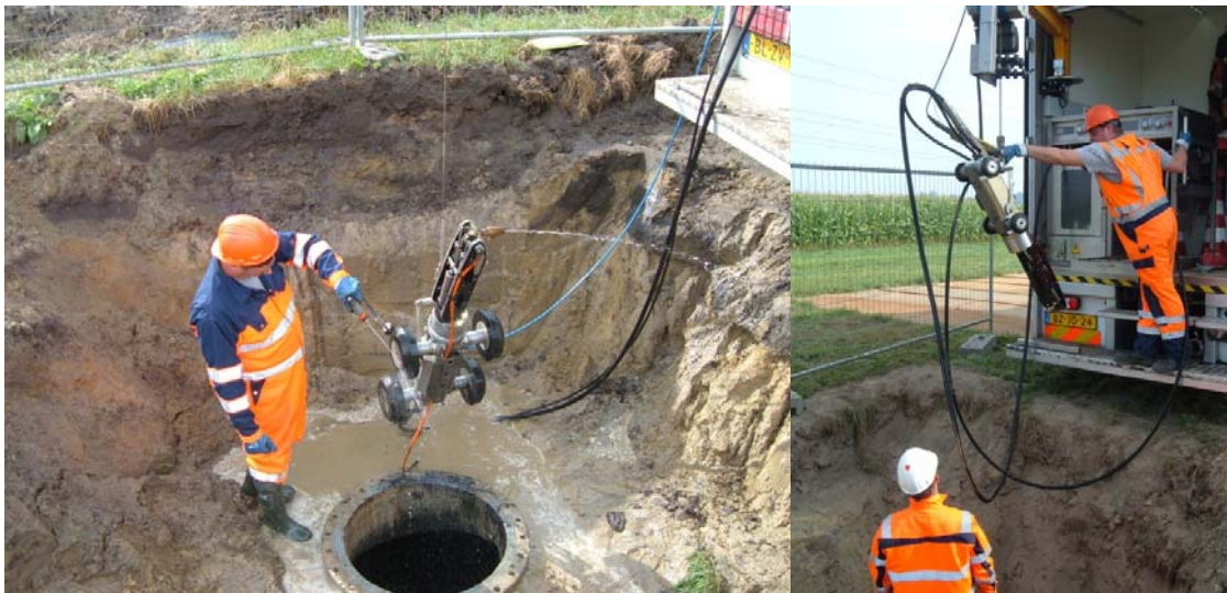
Figuur 1.7. Een waterjet zorgt ervoor dat de buiswand schoon wordt gespoten alvorens de camera-inspectie uitgevoerd kan worden.
