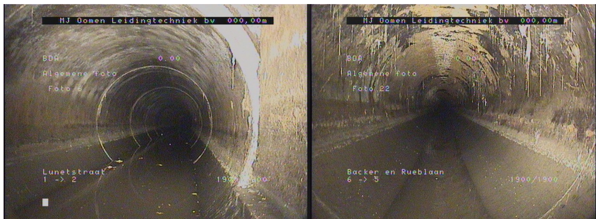
Figuur 1.8. Een impressie van camerabeelden van de influentleiding van de rwzi Nieuwveer tijdens de inspectie
