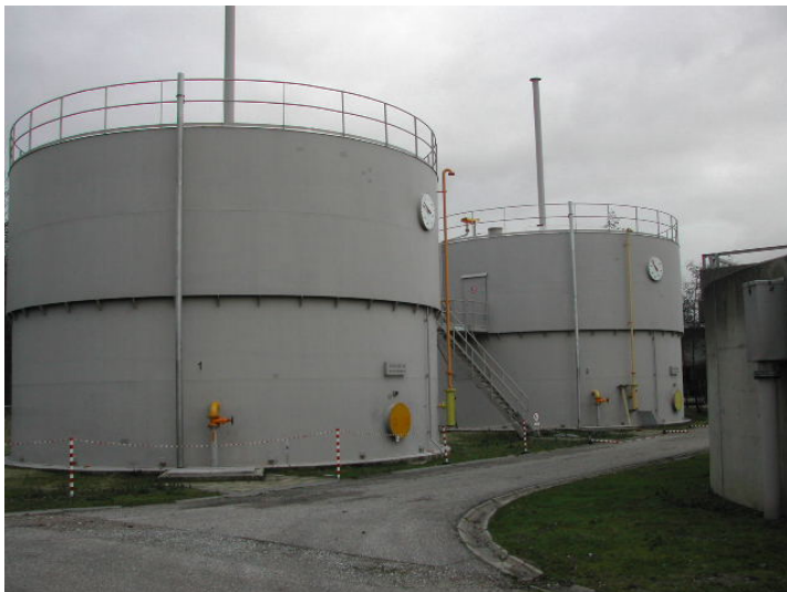
Figuur 5.1. Gashouders op de rwzi Bath.
