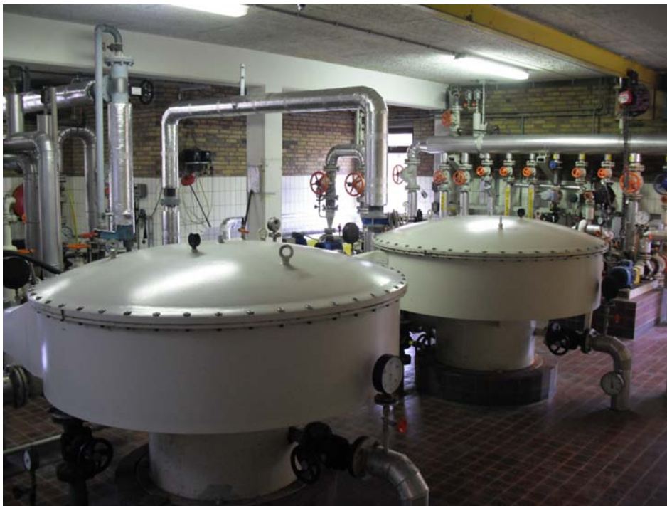
Figuur 7.2. De warmtewisselaars op de rwzi Bath
