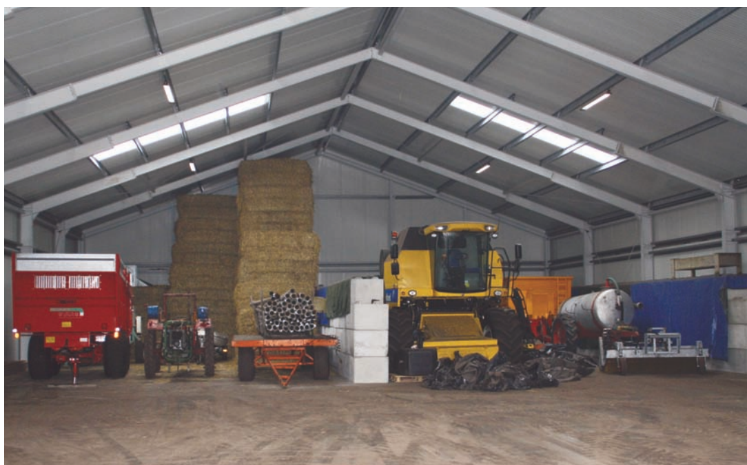
Op het akkerbouwbedrijf van de familie Moed zijn onlangs twee nieuwe loodsen gebouwd voor stalling en opslag.
