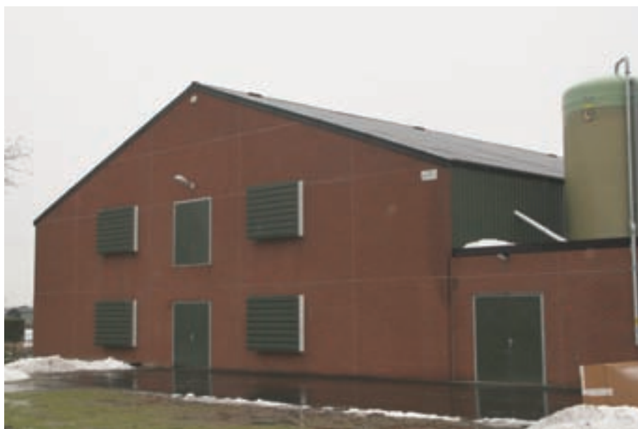
De etagestal van Briels heeft een hoogte van bijna tien meter. Achter de damwand aan de voorzijde zitten extra inlaatventielen die open worden gezet bij extreme warmte.
