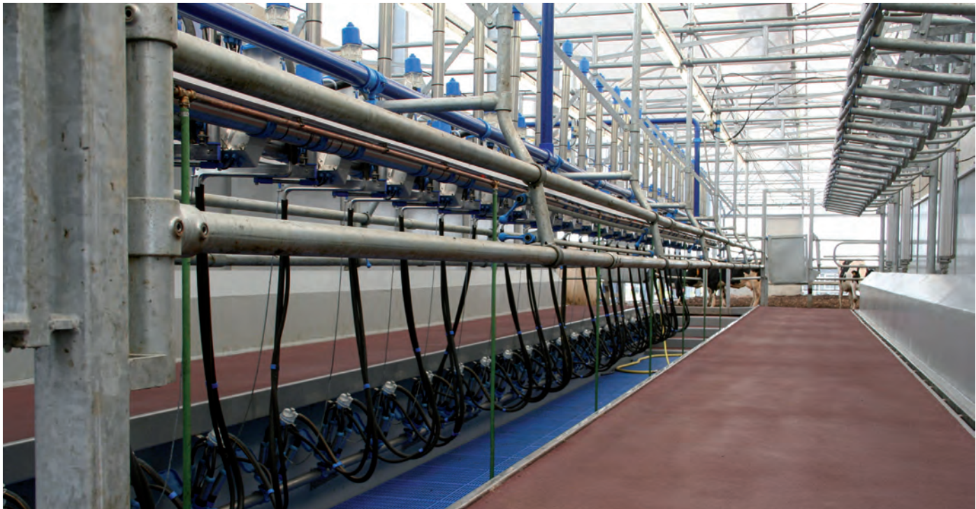
Na een aantal jaar met melkrobots te hebben gewerkt, is Gerard Hoogland overgestapt op een Dairymaster 26-stands swing-over melksysteem.
