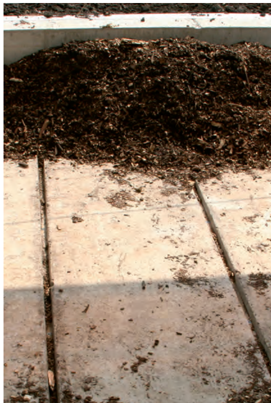
Om de 90 centimeter zijn pvc-buizen in het beton geplaatst, met daarin elke 90 centimeter een gat waardoor lucht wordt geblazen.
