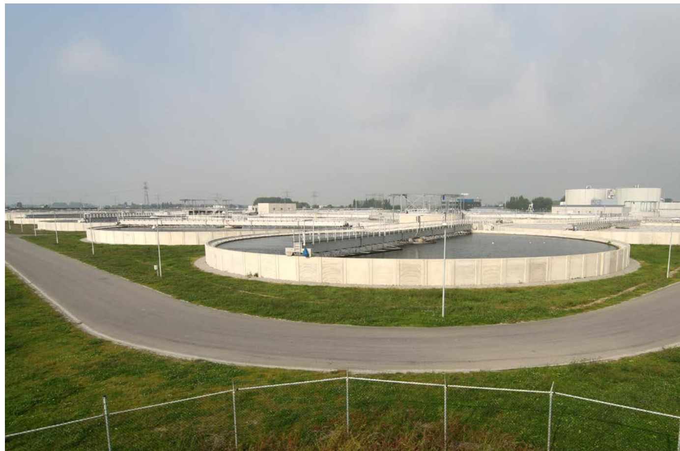
Foto Zuiveringsinstallatie voor drinkwater
