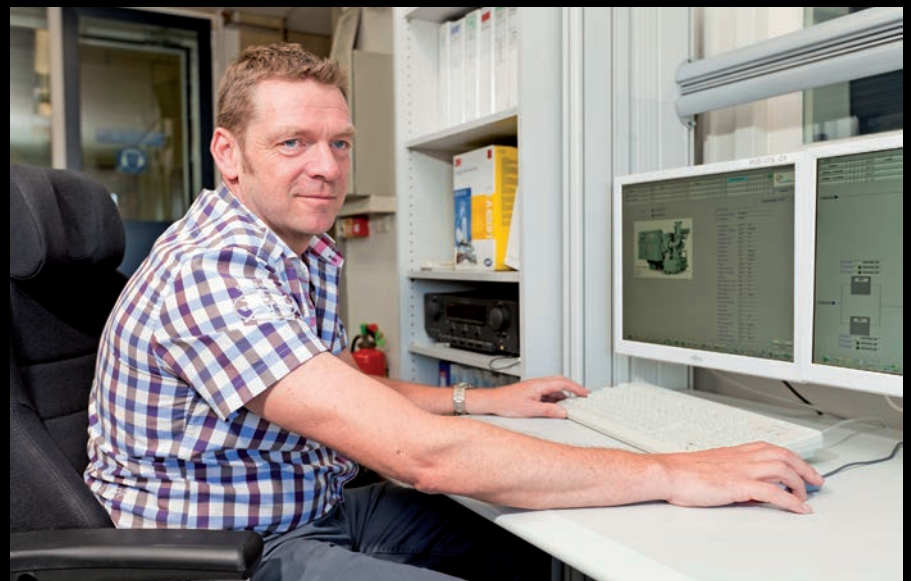
Noud Langenberg is bij FrieslandCampina DMV in Veghel verantwoordelijk voor de perslucht. Met behulp van een visualisatiesysteem wordt de persluchtinstallatie gemonitord. De persluchtinstallatie voldoet aan de allerstrengste eisen.
