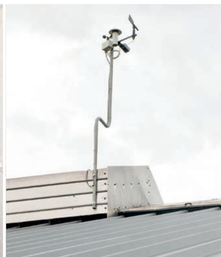
Weerstation stuurt klimaatcomputer aan
