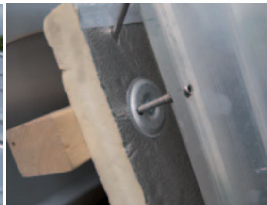
Met stokschroeven worden de profielen op de juiste afstand van de gording gemonteerd. Kromme gordingen zijn geen probleem.
