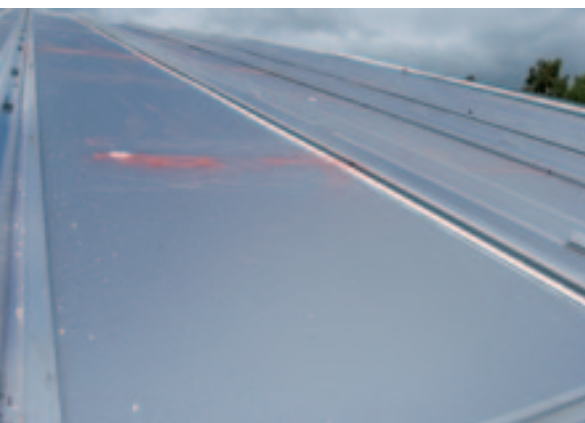
De lengteprofielen worden op de gordingen geschroefd. Isoleren met Recticel kan als de klant dat wenst.
