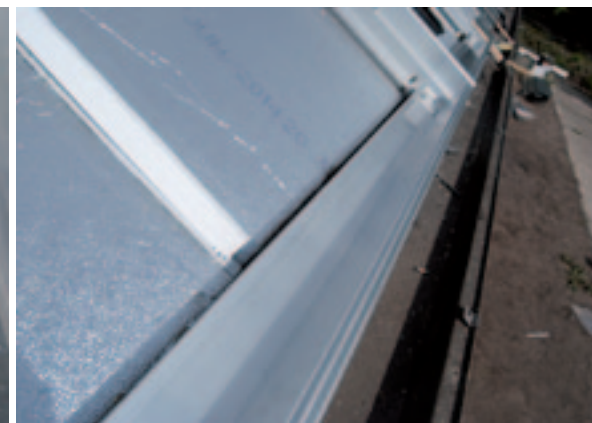
Na de lengteprofielen worden dwarsprofielen gemonteerd. Onderaan komen eindprofielen.
