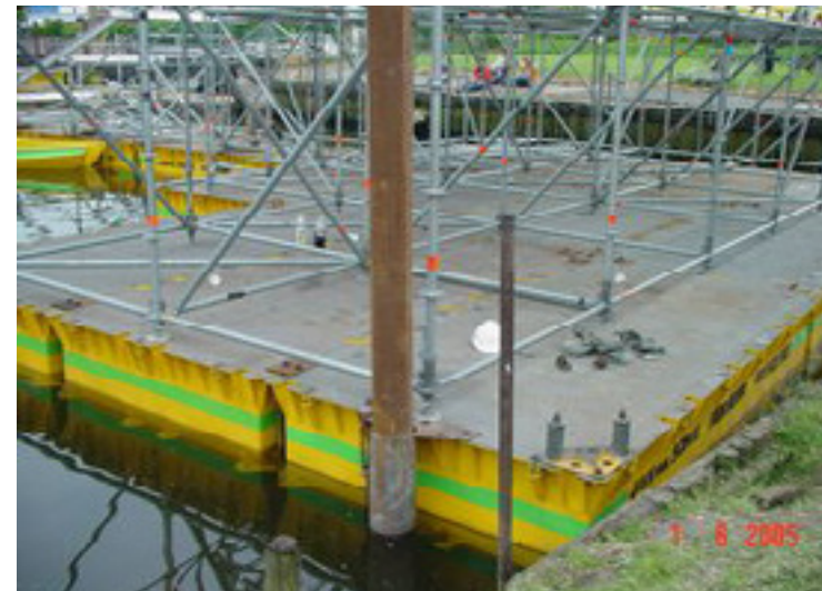
Figuur: 5.12 stalen containers in gebruik bij bouwwerkzaamheden Bron: http://www.degraaf.nu
