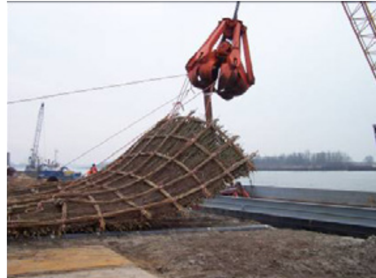
Figuur: 5.14 gevlochten wilgentenen matten worden terplaatse gerealiseerd Bron: http://www.innoverenmetwater.nl
