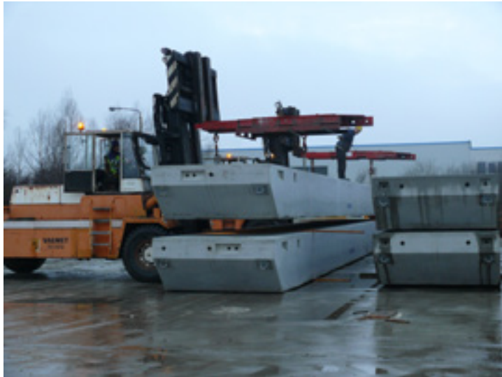
Figuur: 5.3 de gesloten betonnen bak Bron: http://www.buga-2009.de
