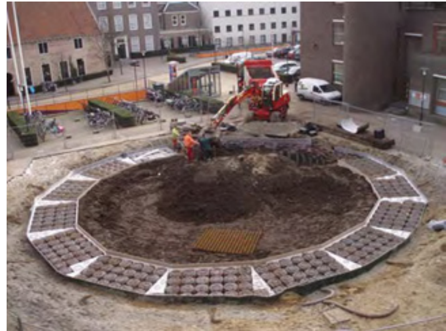
Figuur: 7.18 Watershells in aanbouw onder toekomstige rotonde Bron: Totaal-documentatiemap.waterblock.BV
