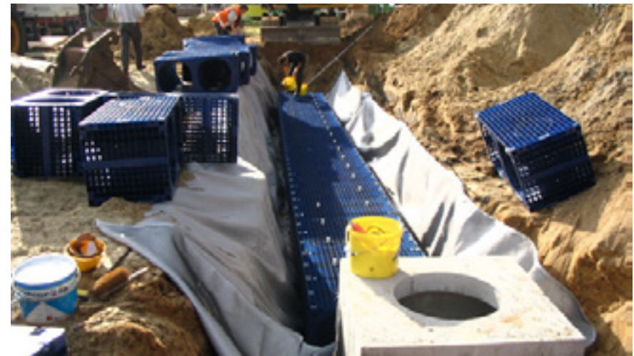
Figuur: 12.4 aanleg van waterinfiltratiekratten Bron: raabkarcher.nl
