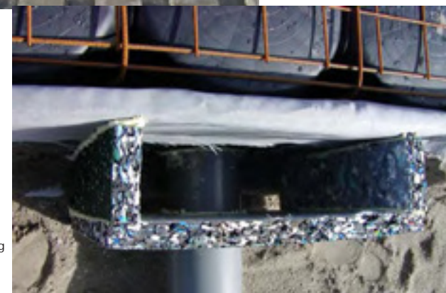
Naaststaand Figuur: 7.17 watershell systeem in aanleg met XPE Bron: Totaal-documentati- emap.waterblock.BV
