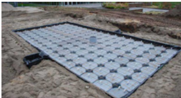
Figuur: 12.5, Watershells in aanleg, klaar om het betonnen dek op te storten Bron: www.waterblock.com
