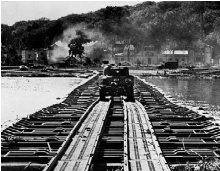
Figuur: 2.17 mobiele drijvende brug in de Tweede Wereldoorlog van de Engelsen Bron: www.forum.fok.nl
