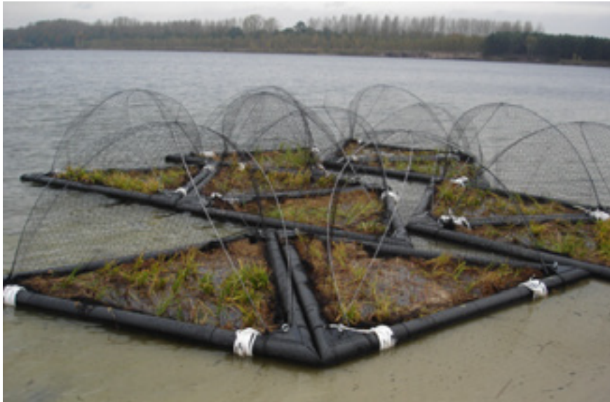
Figuur: 5.15 drijvende cylinders, gekoppeld met kunststofouw Bron: http://www.tributegreenfix.nl
