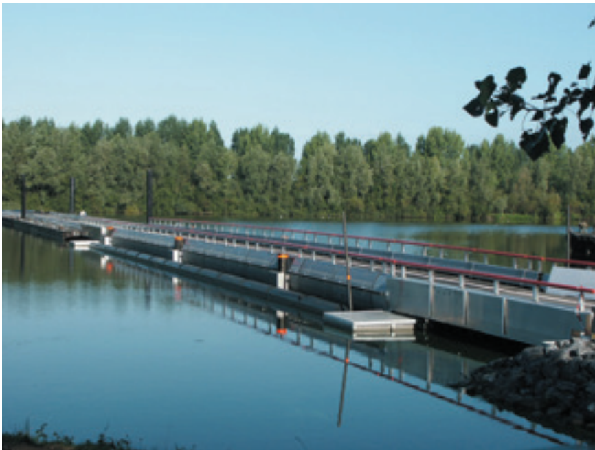
Figuur: 2.18 de drijvende brug uit 2003 in Hedel, Nederland Bron: www.ecoboot.nl
