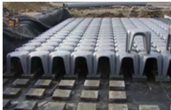
Naaststaand Figuur: 7.16 watershell systeem in aanleg Bron: Totaal-documentati- emap.waterblock.BV
