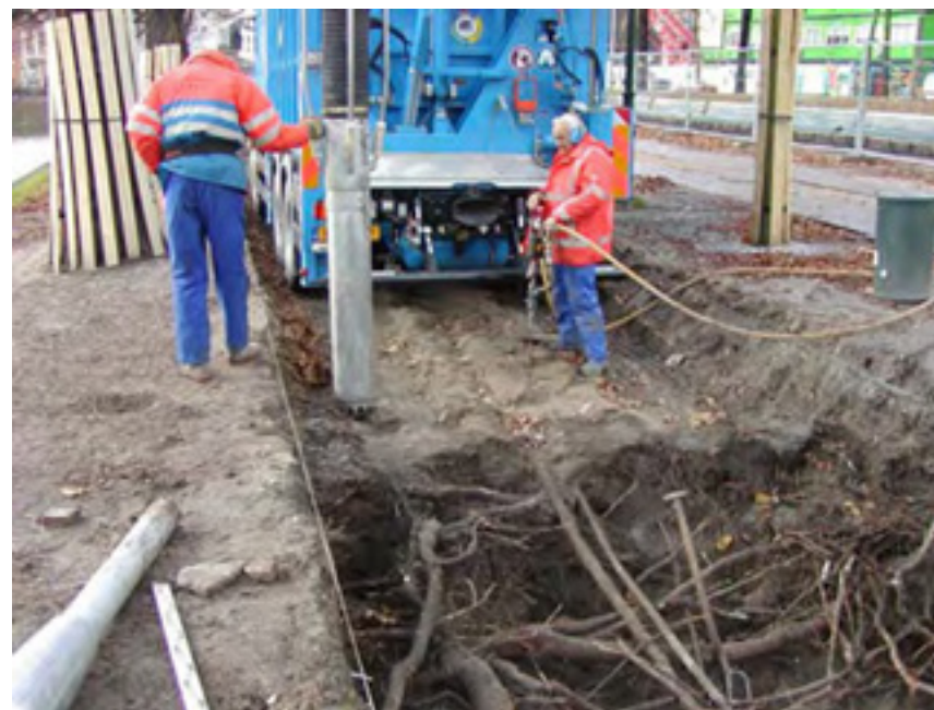
Figuur: 9.1 bodem vervanging met een grondzuiger Bron: Totaal-documentatiemap.waterblock.BV
