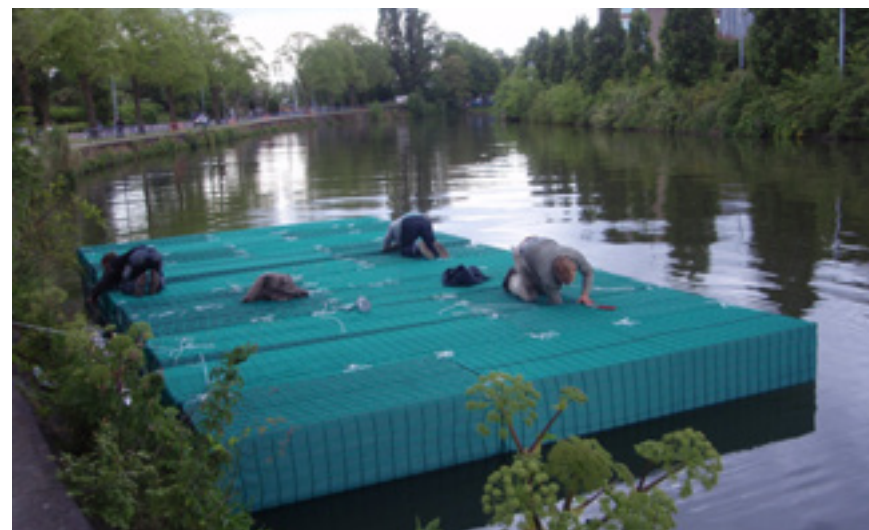
Figuur: 5.17 EPS blokken overspannen met netten die ook als koppeling dienen Bron: http://blijvendrijven.blogspot.com
