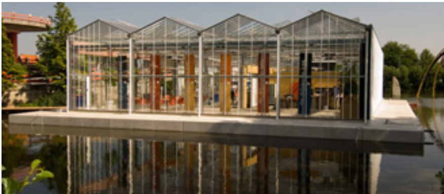
Figuur: 5.7 de drijvende kassen in Naaldwijk op EPS met een staalvezelbeton top Bron: http://www.water-in-zicht.nl
