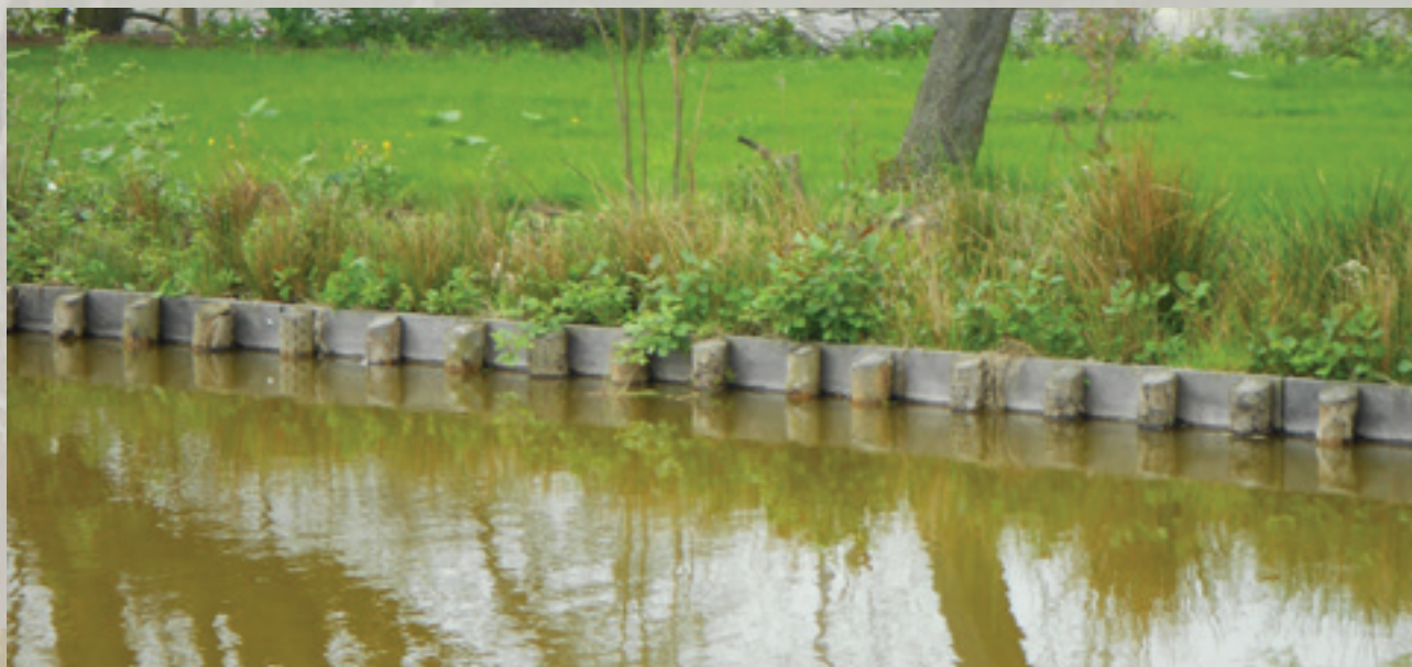
boven fig. 2.31 - U-profiel beschoeiing, onder fig. 2.32 - Traditionele beschoeiing langs Reeuwijkse Plassen
