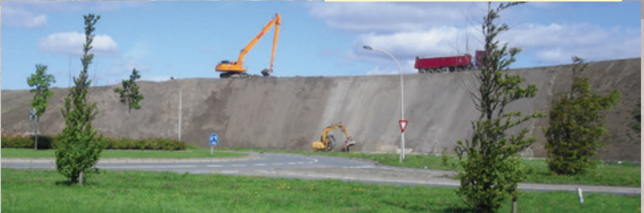
fig. 2.21 - De aanleg van een geluidswal in Zuid-Holland
