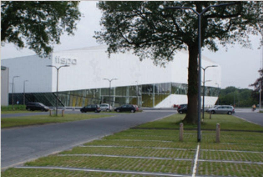
links fig. 2.7 - Grasbetontegels, rechts fig. 2.8 - Poreuze betonstraatstenen
