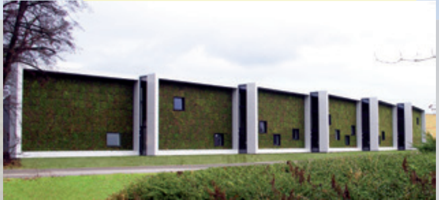
fig. 2.29 - Gevelgroen te vervanging van spouwmuur in Aalten
