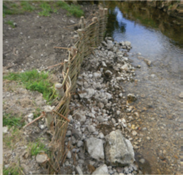
fig. 2.33 - Vlechtwerk beschoeiing langs beek
