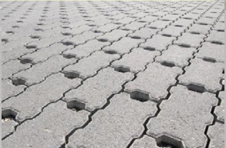
links fig. 2.5 - Betonstraatstenen met verbrede voeg, rechts fig. 2.6 - Betonstraatstenen met drainageopeningen
