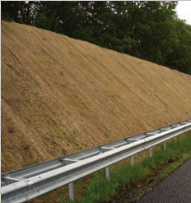
links fig. 2.2 - Biologisch geotextiel kort na aanleg, rechts fig. 2.3 - Stapelzoden kort na aanleg
