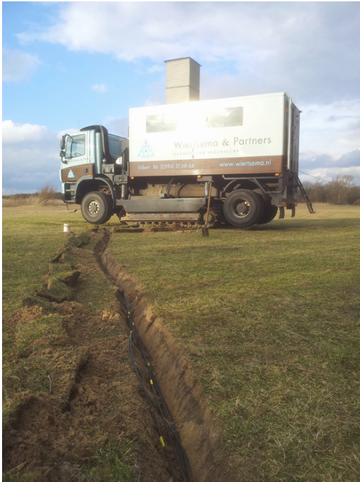
Afbeelding 4b. De kabels worden ondergronds richting een pompkelder gevoerd
