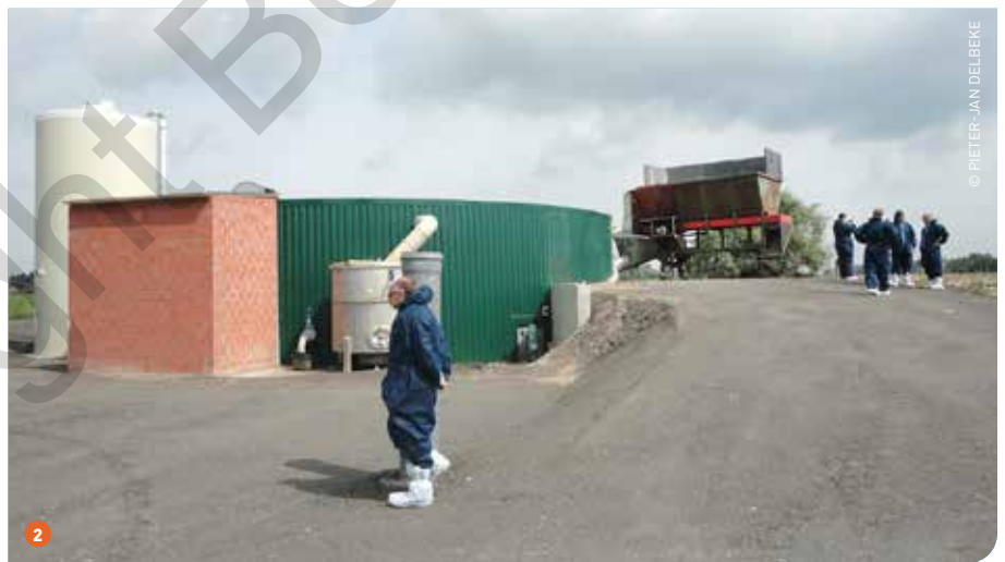
1 Zicht op de biologische mestverwerking (met zonnepanelen op de loods van de compostering). 2 De vergister waarin biogas wordt geproduceerd, achteraan de invoerbak met vijzel naar de tank.
