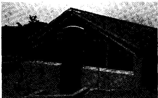
7. Kasje met z.g.n. zwevend dak te Zürich-Zollikon voor teelt van potplanten: Patenthaus, 3 m breed
