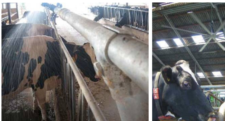
Fig. 4.2 Directe evaporatieve koeling in de stal 75 (links) en ventilatorunit in melkveestal 76 (rechts).
