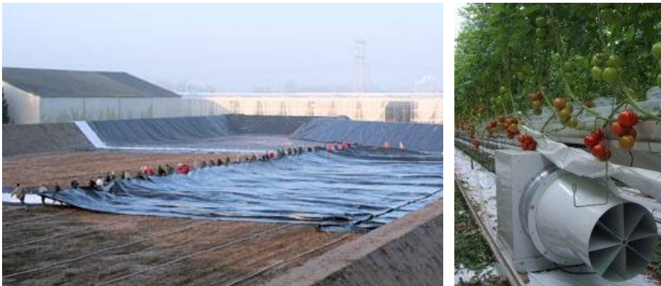
Fig. 3.19 Aanleg van een regenwaterbassin 65 (links) en een luchtbehandelingskast 62 (rechts).
