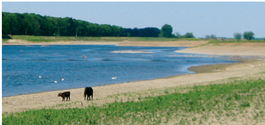
Figuur 2 rivierverruiming langs de Grensmaas ten noorden van Maastricht, mei 2012 bij een afvoer van 155 m 3 /sec. Deze of lagere afvoer komt op circa 75 dagen per jaar voor. Op de voorgrond de afgegraven oever bij Borgharen en op de achtergrond (overzijde Maas) de gerealiseerde Boertien-locatie Hochter Bampd (België). Foto: Hettie Meertens, ARK Natuurontwikkeling.
