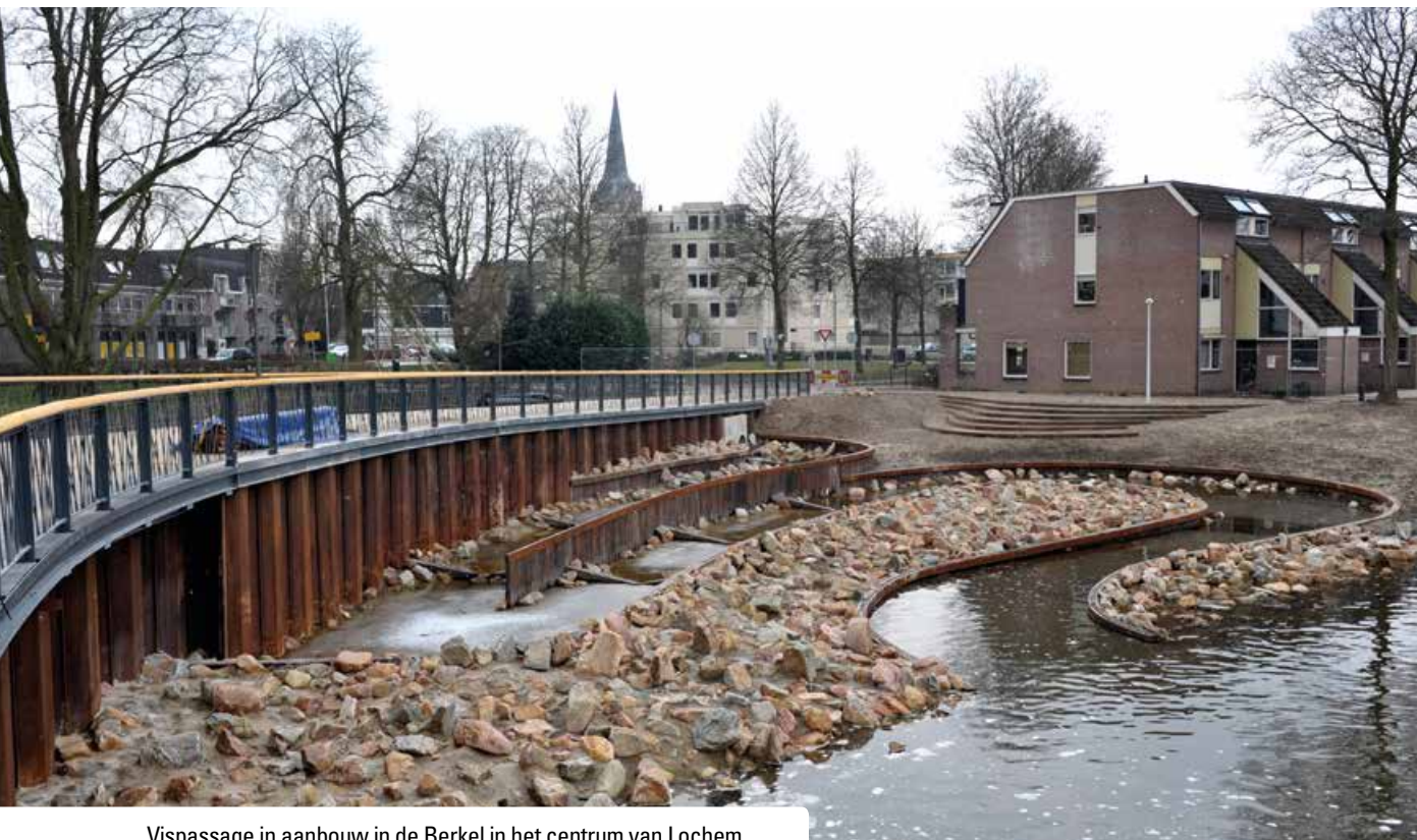
Vispassage in aanbouw in de Berkel in het centrum van Lochem.
