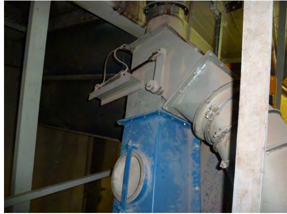
Afbeelding 26 en Afbeelding 27 Voorbeelden van klepkasten direct onder de afvoer van de pers.
