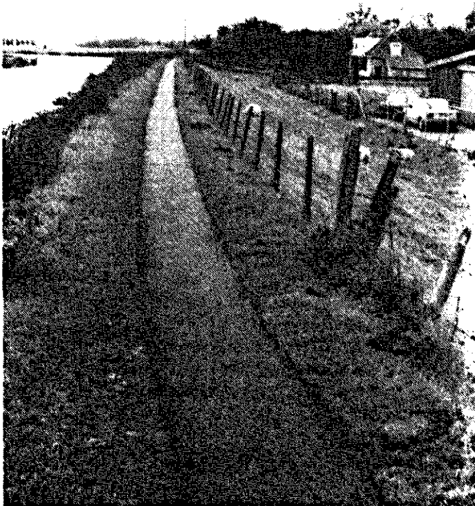
Afb. 1 Nieuw aangelegd fietspad.
