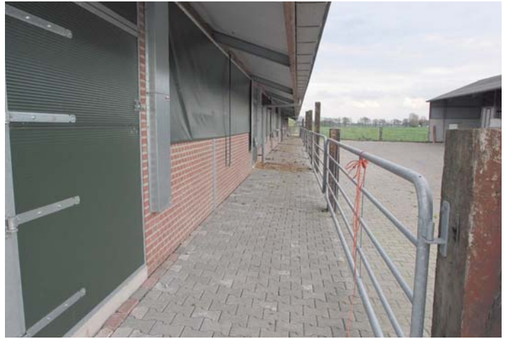
De stal voor de droge koeien, kalveren en stieren telt vijf afdelingen, die alle een uitgang naar de gang aan de buitenkant van de stal hebben. Op deze manier kan één persoon alleen het vee van een afdeling verplaatsen.
