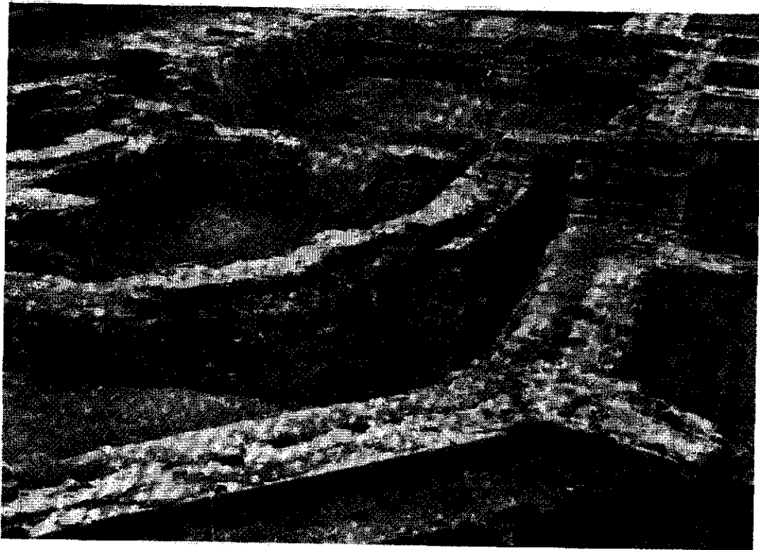
Fig. 81 Fundering van kerken in Grubbenvorst, opgegraven door P. Glazema. Op de voorgrond is het latere koor te zien, gebouwd van kalksteen (mergel). Daarbinnen ligt de fundering van het oudere koor, van Maaskeien en een laag tufsteen. De oostmuur van het schip later doorbroken naar het koor, wat erop wijst dat het schip ouder is. Op de achtergrond is de fundering van de latere bakstenen westtoren te zien (Uit: Limburg's verleden 2, 1967)
