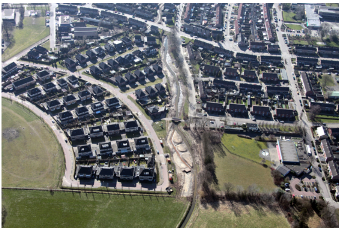
Afbeelding 1. Luchtfoto van de Regge in de bebouwde kom van Gooi, tijdens de uitvoering van de herinrichting Deeltraject 'Hogekamp', het speleiland en enkele vergraven tuinen.
