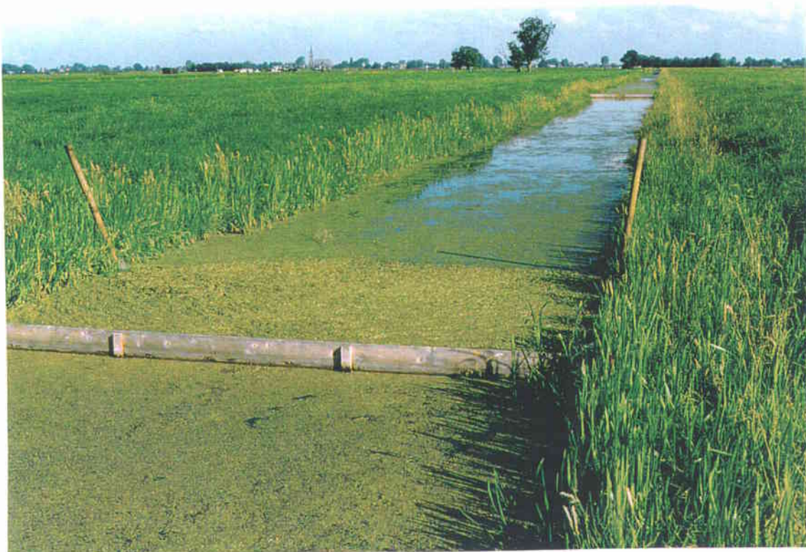
Afbeelding 1 - Sloottraject voor testen van maatregelen, op de waterlijn afgesloten met planken (foto: M. Edelman, BKH Adviesbureau)
