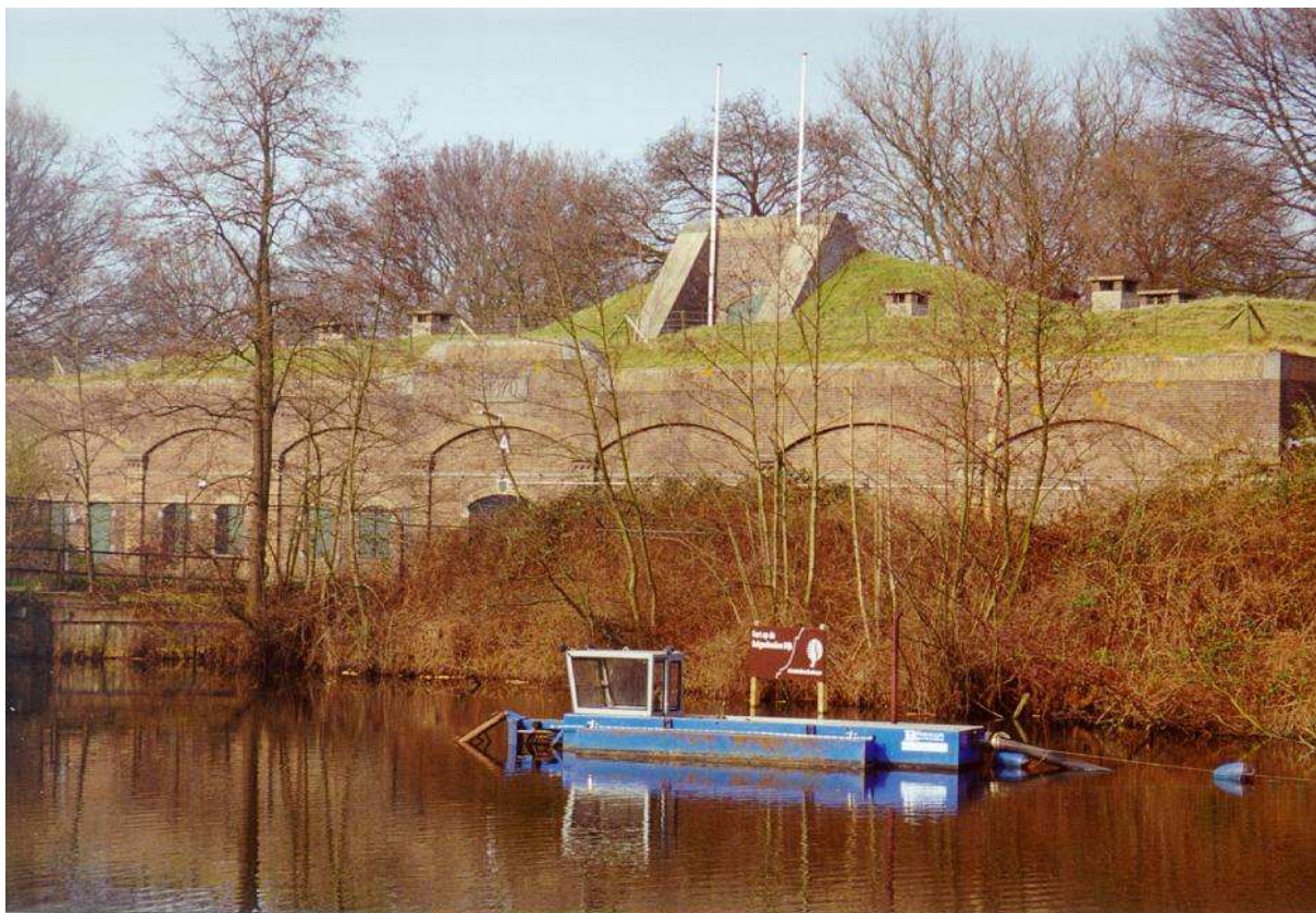
Foto 2. Baggeren van de fortgracht.
