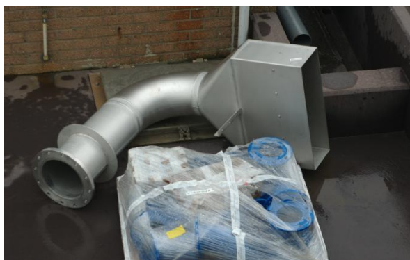
Foto 3.2. De aflatconstructie vanuit de nabezinktank naar de eerste/noordelijke vlooienvijver.
