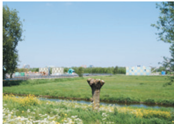
RWZI Amstelveen. Functie: waterzuivering
