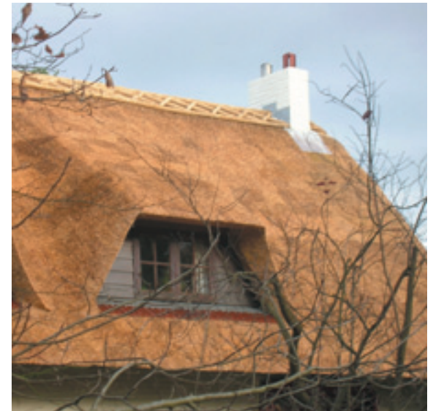
Riet als dakbedekking
