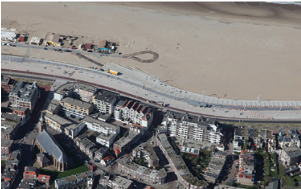
Luchtfoto van de nieuwe boulevard
