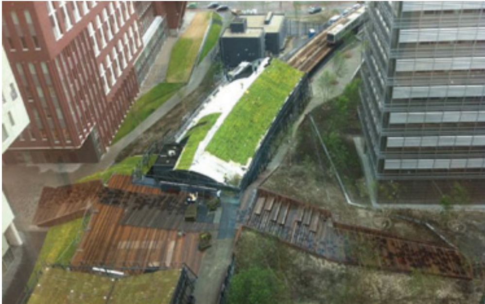
Bovenuitzicht op de bijna afgeronde Ichthushof gezien vanuit de Hogeschool InHolland
