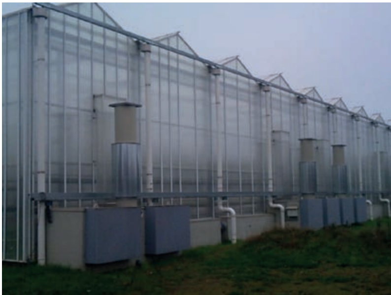
Figuur 22. LBU's met geluidsdempende omkastingen aan de inblaaszijde en de uitblaaszijde.
