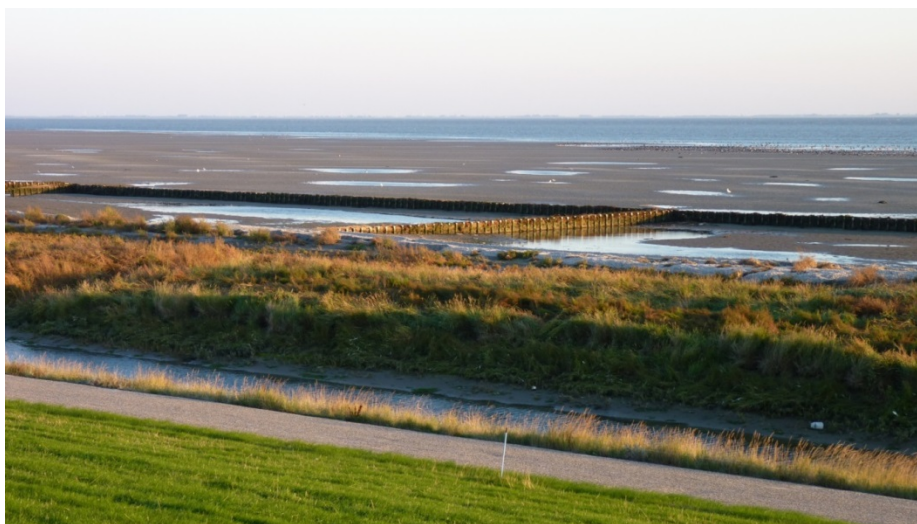
Figuur 7. Kwelderbescherming door middel van rijshoutdammen en kleisuppletie langs de kwelderrand op de Feugelpôle, Ameland (foto: Alma de Groot).
