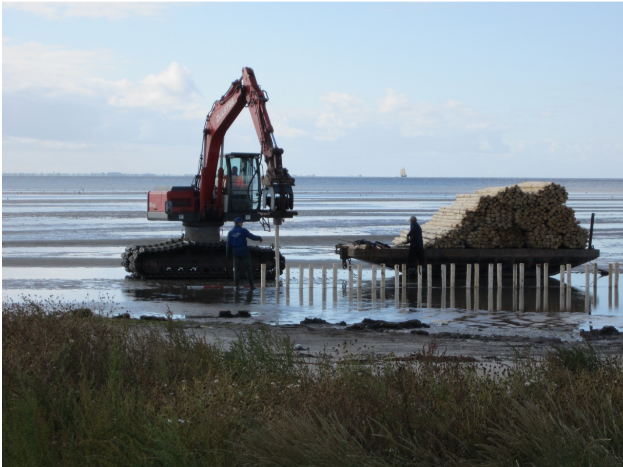
Figuur 9. De aanleg van rijshoutdammen (foto: Alma de Groot).
