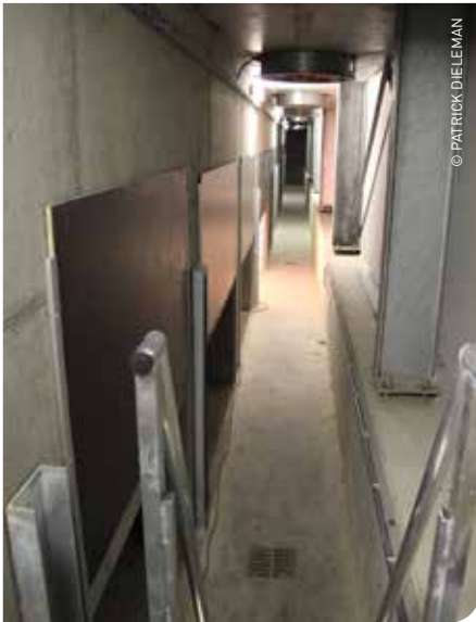
De volledige drukgang werd door Dirk Gilleman zelf uitgevoerd in ter plaatse gestort beton.
