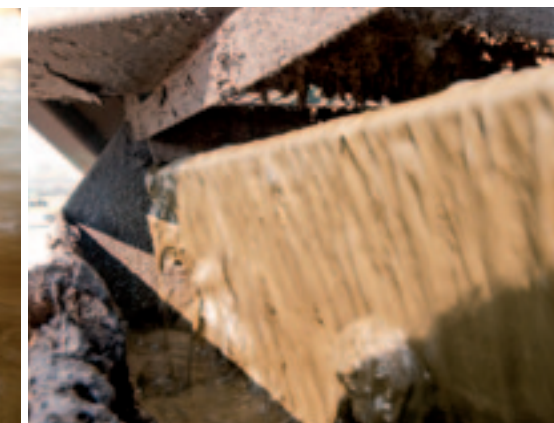
In het bad wordt perslucht toegevoegd waardoor zand en grove delen scheiden. Via een overloop gaat de mest naar de eerste put.
