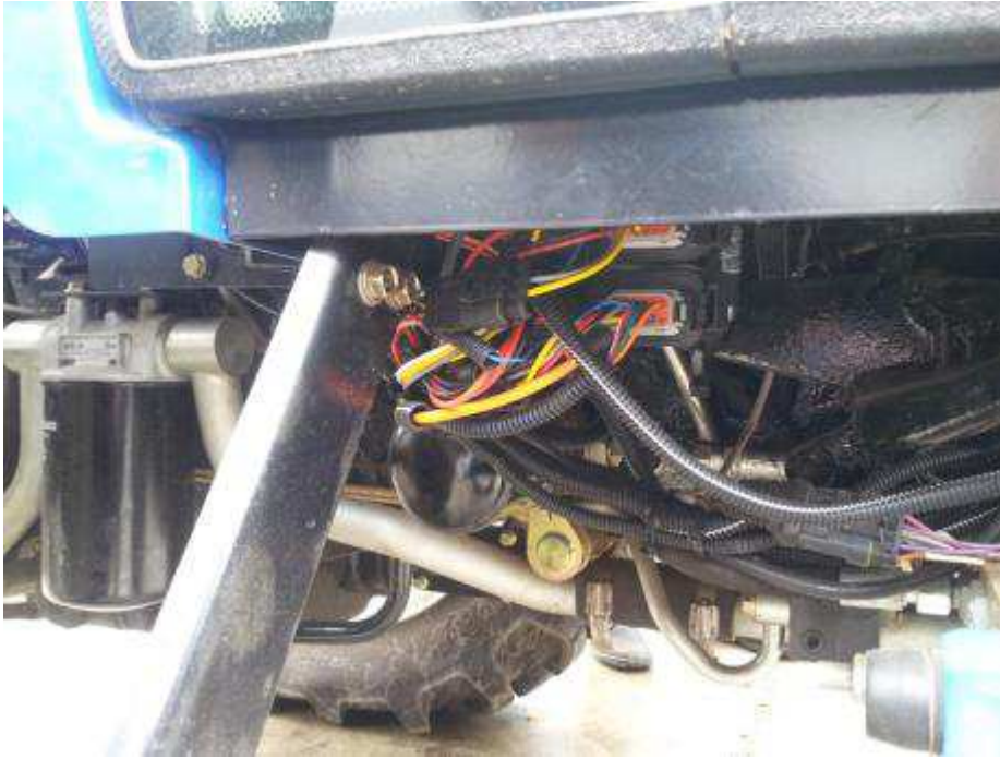
Figuur 7. De Safety Control Module en de Steering&Engine Control Unit onder de rechter treeplank.
