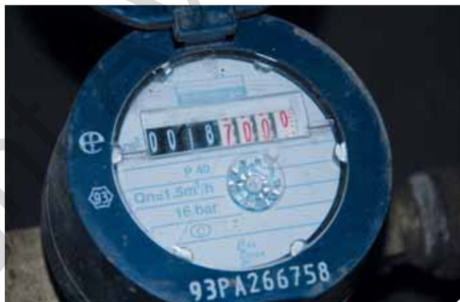
▲ Vanaf 1 januari 2010 moet elke grondwaterwinning beschikken over een verzegelde watermeter.
