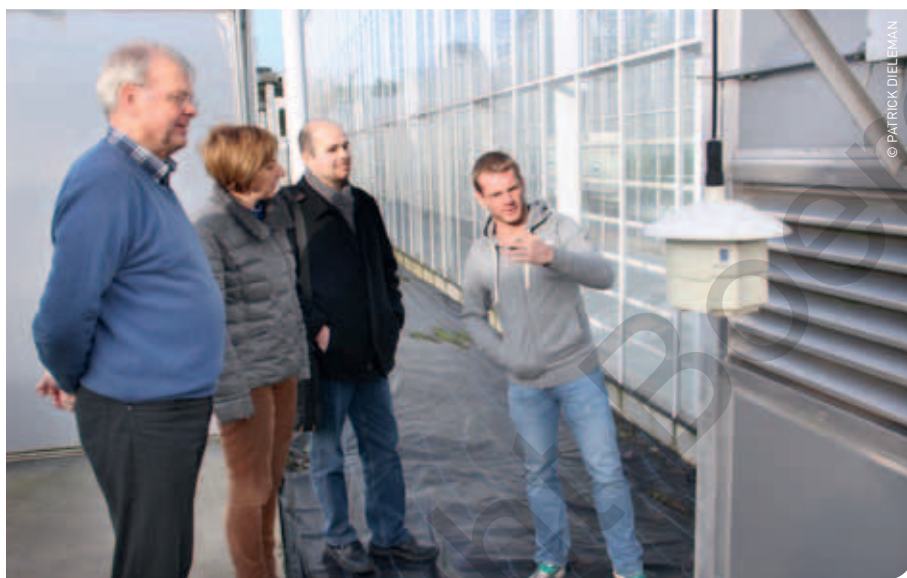
Dave Pinxteren (rechts) discussieert met de andere gesprekspartners over de werking van de luchtbehandelingsunit, die buiten de kas is opgesteld. V.l.n.r. Ward Baets, Lieve Wittemans en Mathias Coomans.
