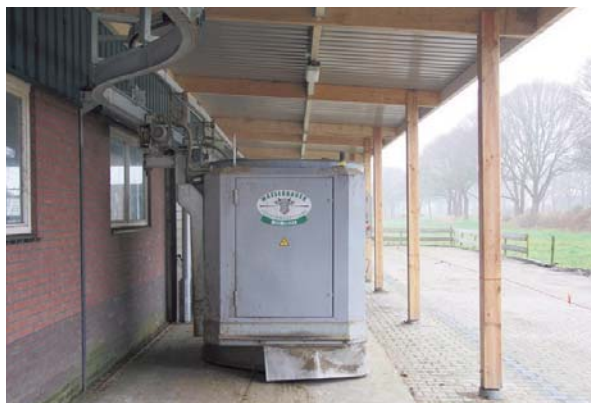
Om de voerkar droog van de ene naar de andere voergang aan weerszijden van de stal te laten rijden, hebben de broers Enting een luifel aan de voorkant van de stal gebouwd.
