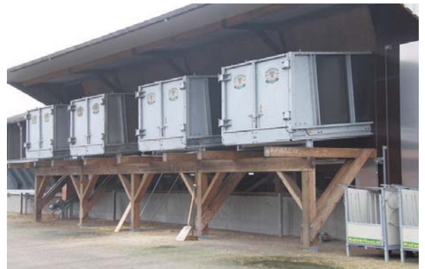
Van de vier op hoogte geplaatste voorraadbunkers zijn er twee voor graskuil, een voor maïs en een voor stro. In een bunker kunnen vijf kuilblokken tegelijk worden geplaatst.
