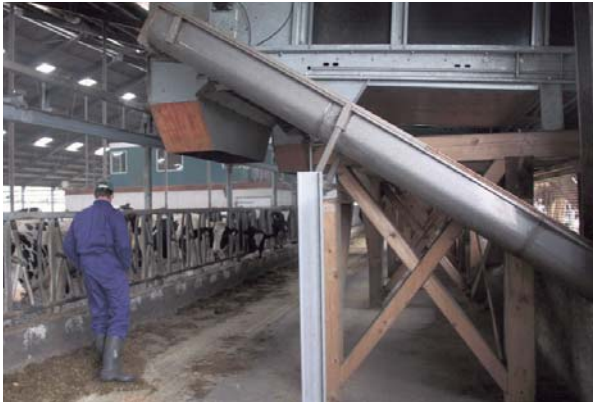
De voorraadbunkers zijn op hoogte geplaatst. Op de voorgrond de aanvoervijzel voor de bierbostel, die in een voorraadbak buiten de stal ligt opgeslagen.
