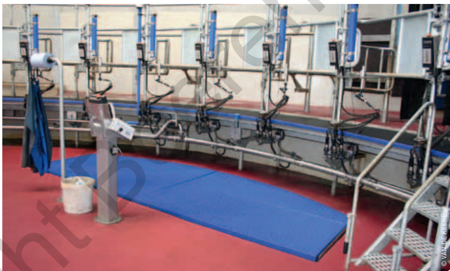
De 32-stands carrousel binnenmelker heeft een in de hoogte verstelbaar werkplatform. Hij melkt 150 koeien in 75 minuten.
